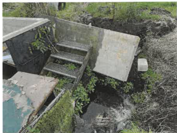
Éléments maçonnés ancien gabion
