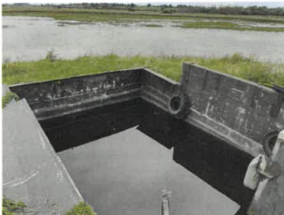
Éléments maçonnés ancien gabion
